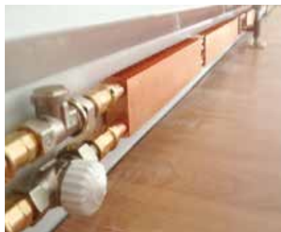
Eingebaute Rohrregister
