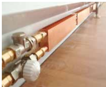
Eingebaute Rohrregister
