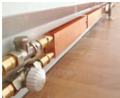
Eingebaute Rohrregister
