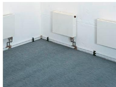
Heizkörperanschluss aus der Sockelleiste
