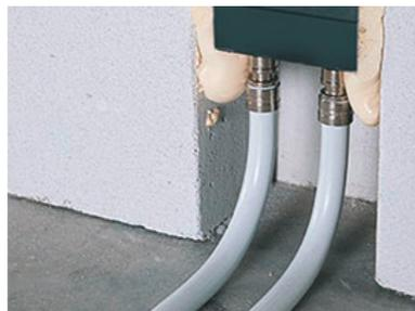
Heizkörperanschluss aus der Wand
