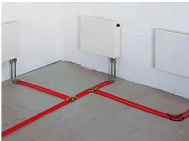
Heizkörperanschluss aus dem Boden
